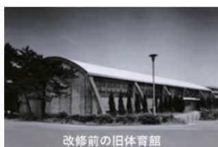
改修前の旧体育館
